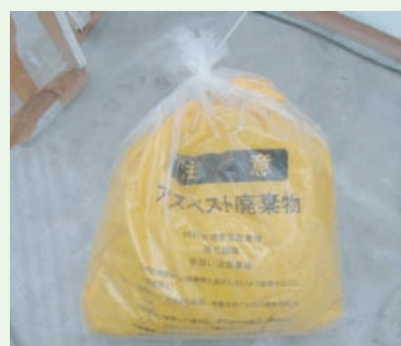
石綿廃棄物の二重袋詰
