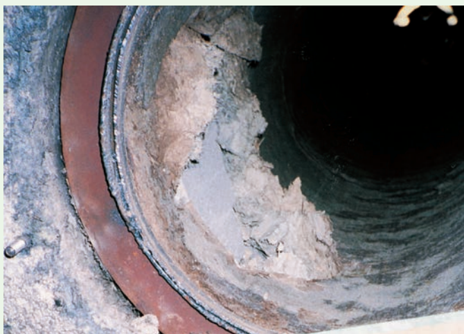
煙突断熱材（ライニング）
