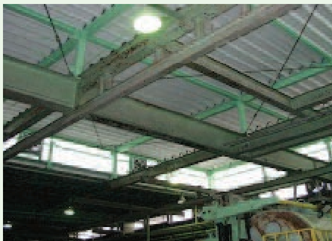
屋根用折版断熱材（折版屋根裏）
