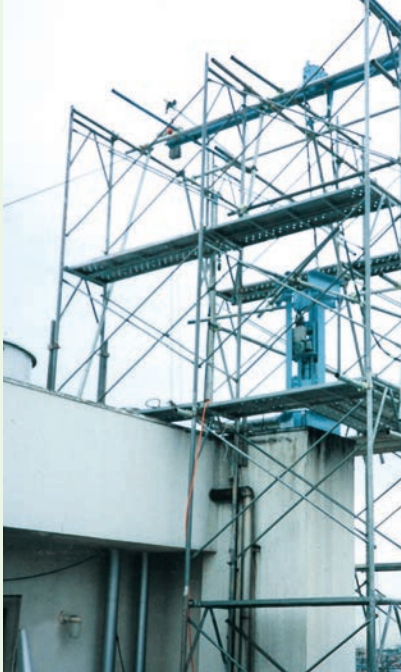
煙突上部及び灰出し口を隔離養生
