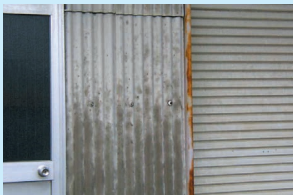
石綿スレート（屋根・外壁）
