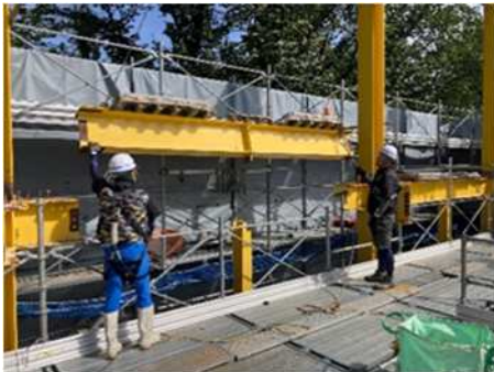
図 7. リユース鉄骨部材（黄色）の取り外し
