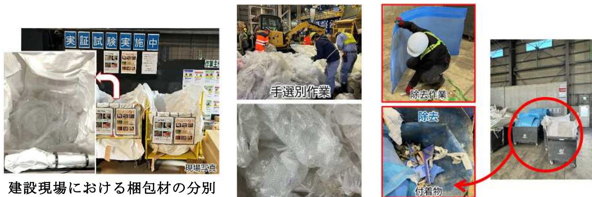
図4 建設系廃プラの回収・前処理の状況
