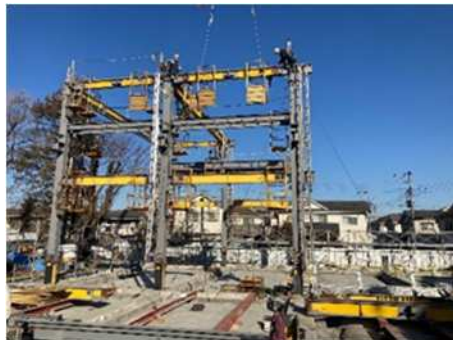
図 14. リユース鉄骨部材の建方
