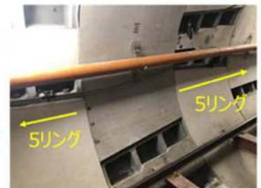
高強度シールドセグメント 設置場所
