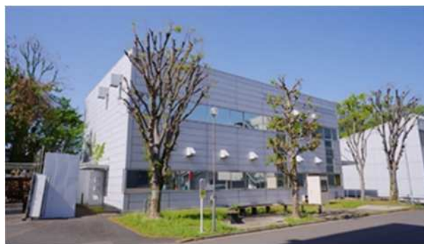
図1. 解体建物：電磁環境実験棟
