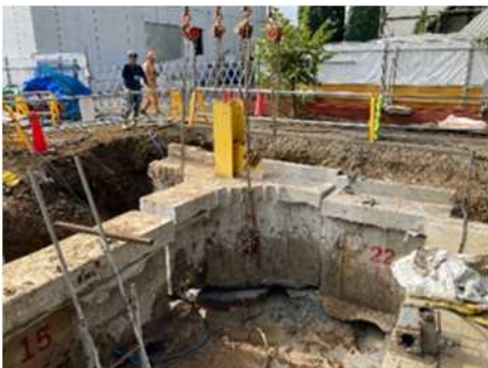
図 8. リユース RC 部材の取り外し
