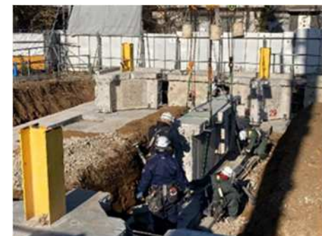
図 11. リユース RC 部材の据付
