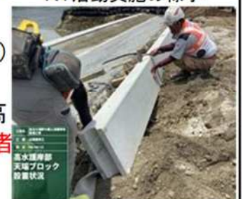
二次製品据付け状況
