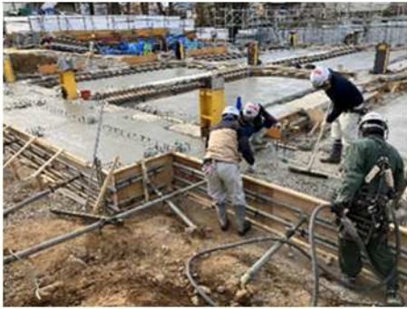
図 13. リユース RC 間拡張部の CON 打設
