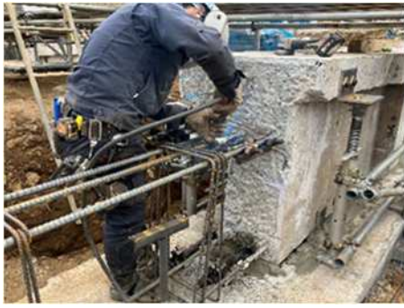
図 12. リユース RC 間拡張部の鉄筋組立
