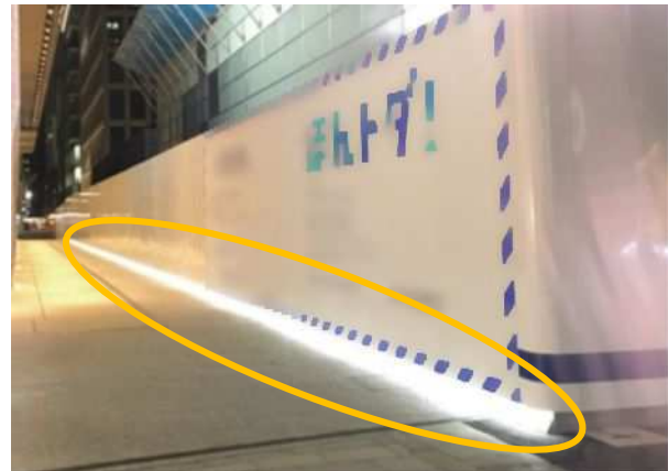
写真10. 仮囲い下のテープライト
