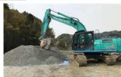
クラッシャーによる破碎処理
