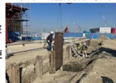
敷鉄板を親杭の間に設置
