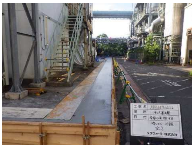
図-1 撤去囲いテントの基礎部均し
