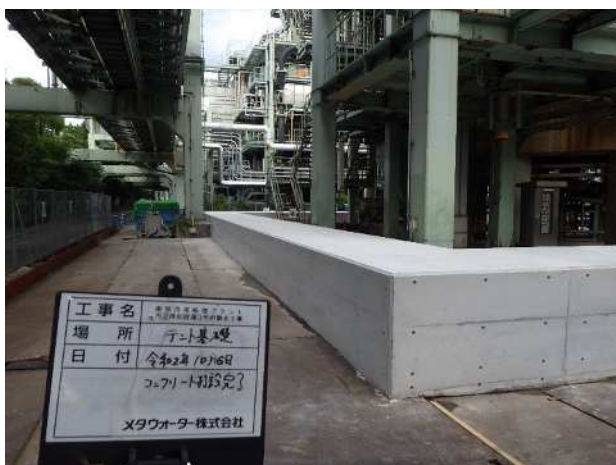
図-3 撤去囲いテント基礎（近影）
