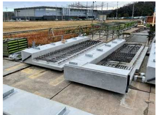
バルコニーのPCaのストック状況
