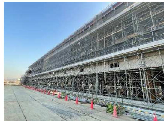
バルコニーのPCa取付状況
