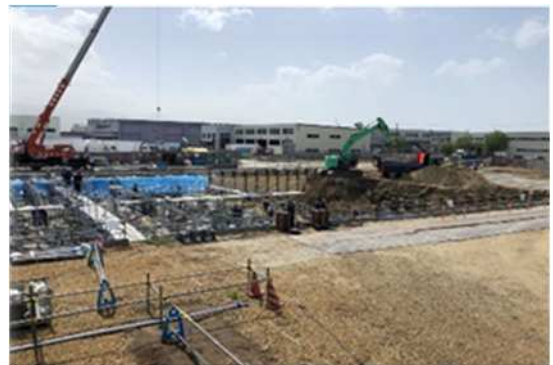
現場発生土搬入埋戻し状況
