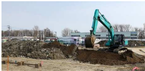
建設汚泥改良状況
