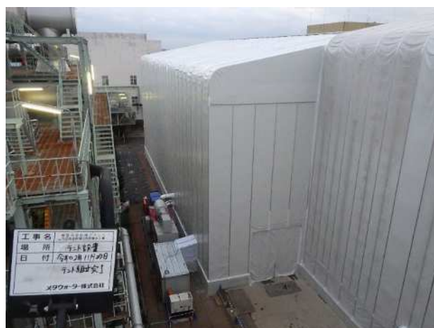
図-4 撤去囲いテント（参考）
