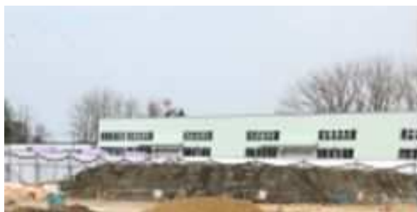
改良土保管状況
