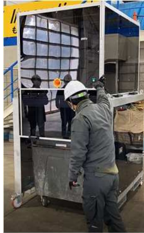
写真8 安全バーを降ろし、 ボタンを押すと圧縮される
