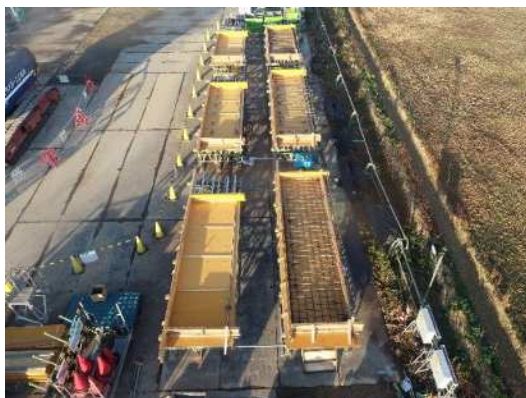
Pca 製作用の型枠設置・配筋状況
