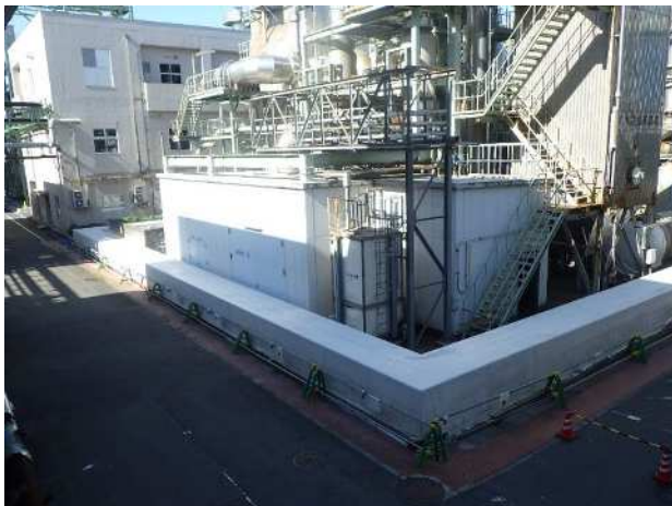
図-2 撤去囲いテント基礎
