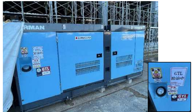
発電機の軽油を一旦除去し、GTLに入替実施
