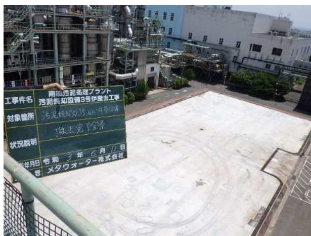
図-6 埋め戻し後の設備ヤード
