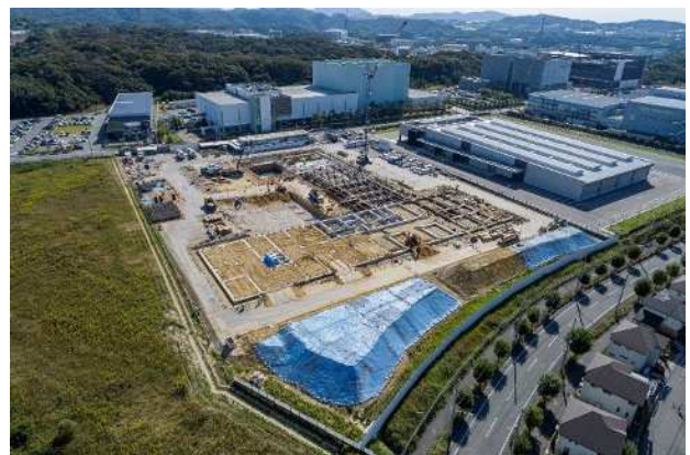
外構で使用する予定の発生残土の仮置き状況
