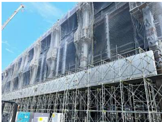
1階垂れ壁の Pca 取付状況
