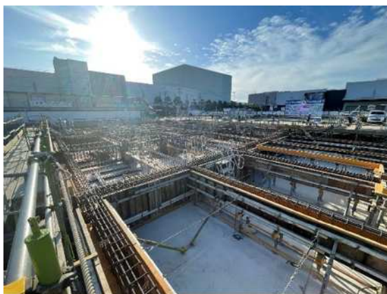
地中梁の木製型枠施工状況
