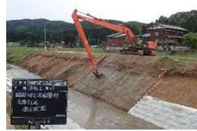
堤体盛土完了後は排水構造物の復旧工事、法面整形後は、大型連節ブロックで法面を被覆し、災害復旧工事は完成しました。
