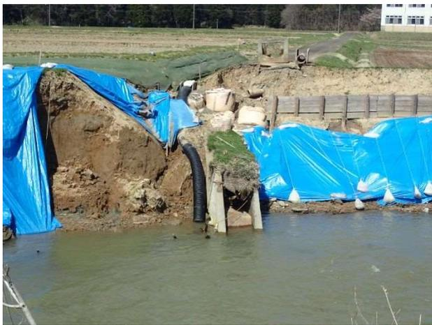
当工事で崩壊した排水構造物は、耕作田の排水の流末に当たる部分で、重要であり機能を停止できません。仮廻しにより流路を確保しながら、堤体盛土と構造物を復旧する必要がありました。
