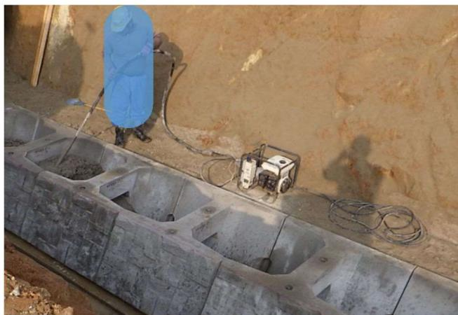
図-2 再生骨材コンクリート打設状況
