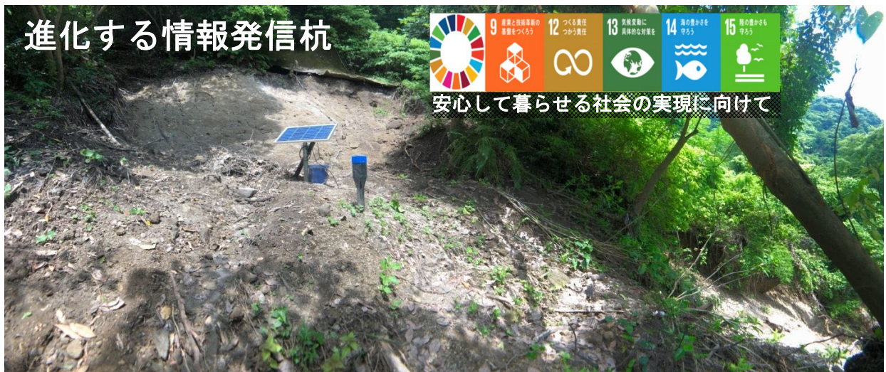
写真5- 鹿児島での新9軸センサ杭設置現場
