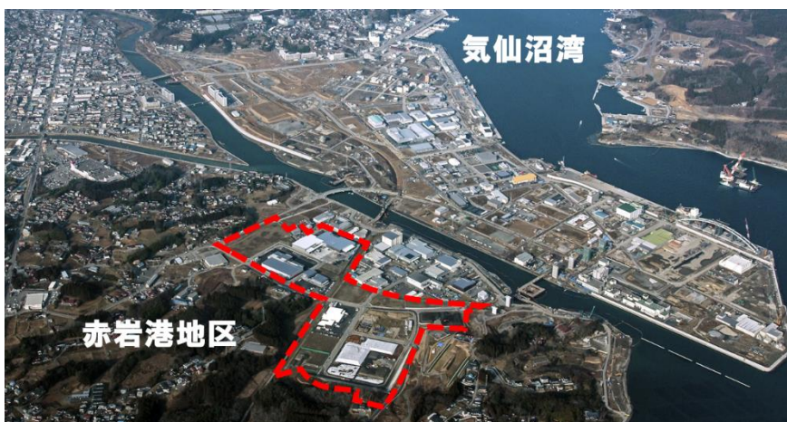
写真-1 施工場所
