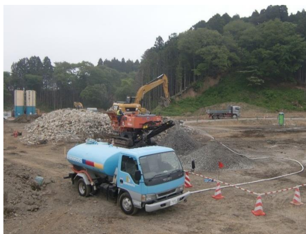
写真-4 自走式破砕器による再生砕石製造状況
