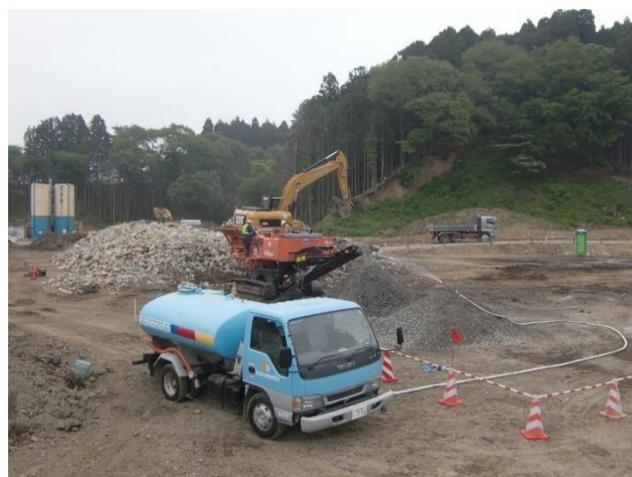
写真-4 自走式破砕器による再生砕石製造状況
