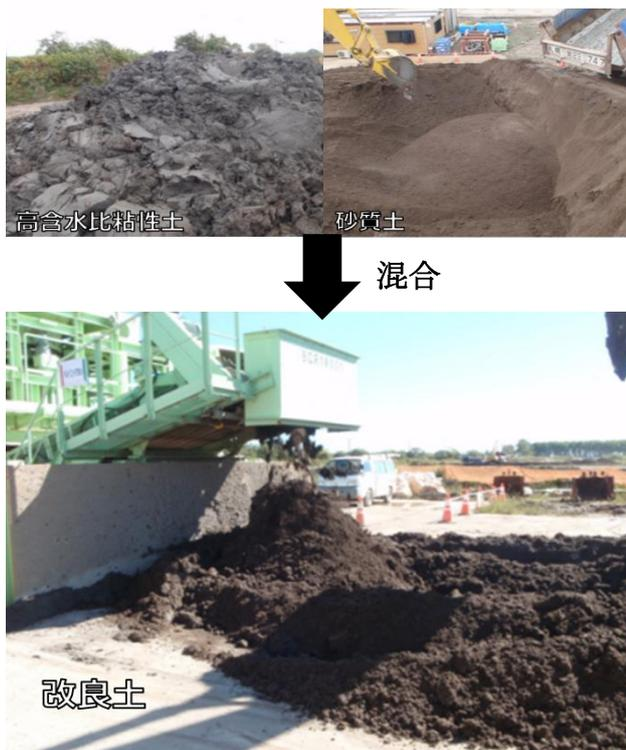
写真-1 高含水比粘性土の改良事例
