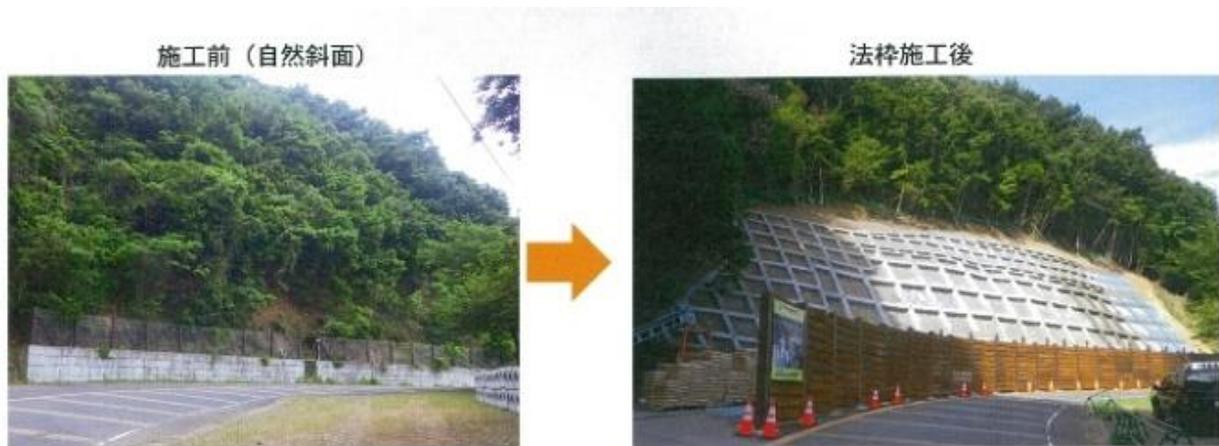
写真-3 法枠工（施工前後の比較写真）
