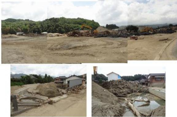
朝倉市の流木と土砂はあまぎ水の文化村というところに集積されていました。この写真から、大量の流木が集められていたことがわかります。流木の幹の部分は処理がしやすいが、株の部分の処理がかなり大変だとのことでした。一方、木の皮の部分は、これも先ほど熊本地震で調査をしたように高さを測ると5mぎりぎり、かなり高く積み上げられ、少し濡れた状態で保管されていました。
