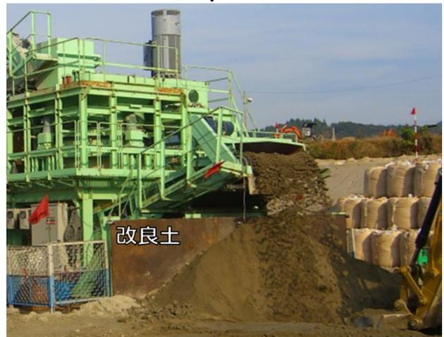
写真-2 軟岩破碎混合の事例
