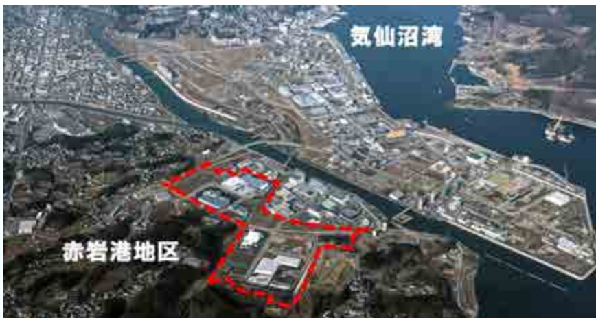
写真-1 施工場所
