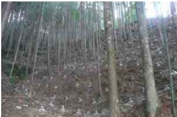
写真-5 熊野古道沿いの施工事例
