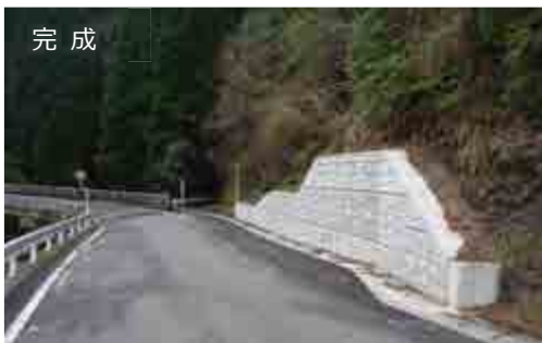
写真-4 掘削残土を低減する施工事例
