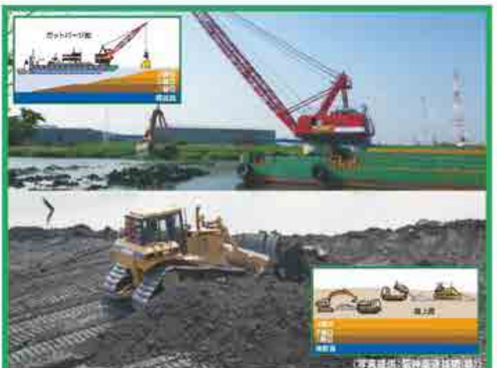
シールドトンネル工事の建設汚泥を埋立てで活用
