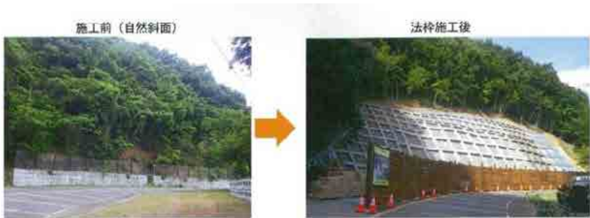
写真-3 法枠工 (施工前後の比較写真)
