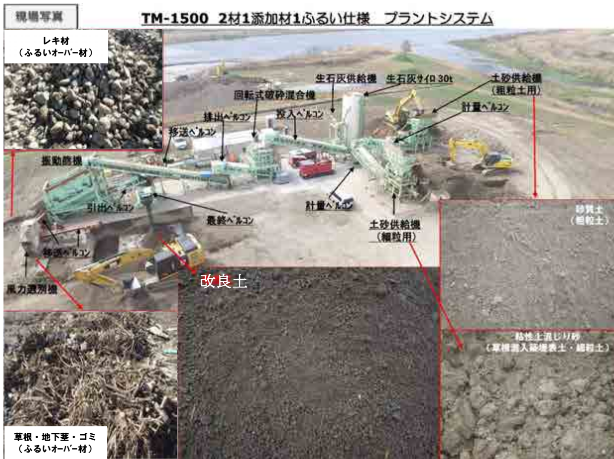
写真-3 草根ゴミ分別を実施した改良事例
