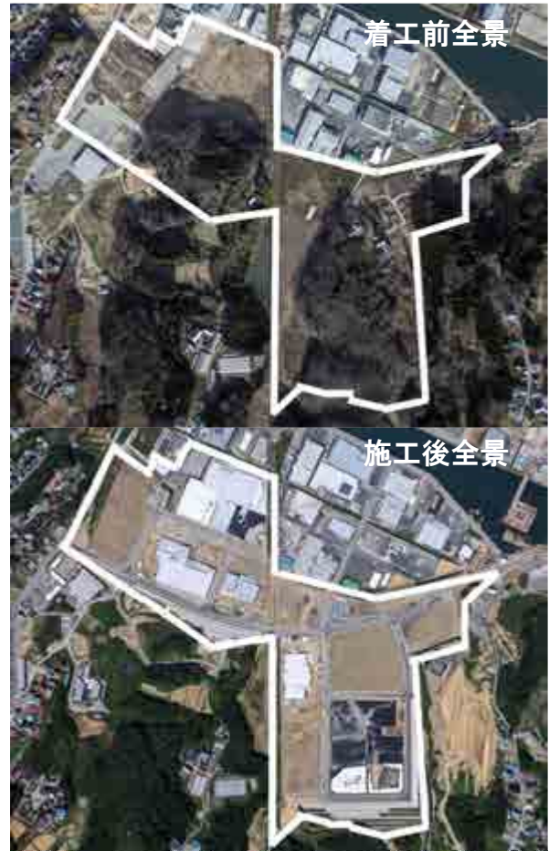
写真-3 着工前施工後全景
