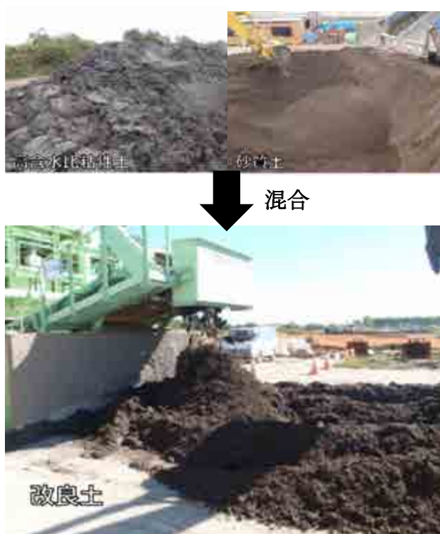
写真-1 高含水比粘性土の改良事例
