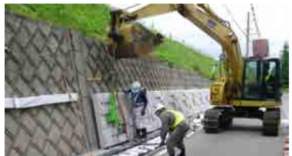
写真-5 産業廃棄物の発生を抑制する施工事例（パネル設置状況）
