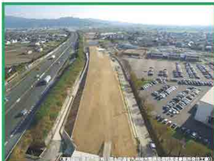
建設発生土を他工事で活用
