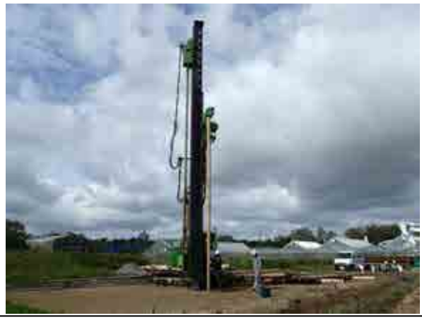
【軟弱地盤対策の実験】 様々な地盤で軟弱地盤対策の実験を実施しました 4) 。
