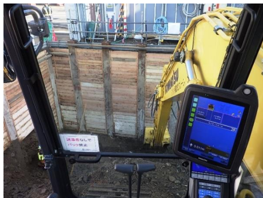
建築現場の基礎掘削土工事 におけるICT施工
