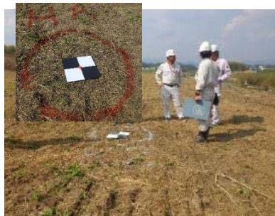
3次元起工測量の準備状況確認
