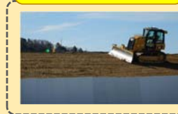
ICT建機を他の作業に利用
