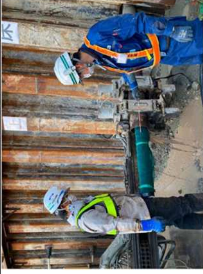
ストレーナー管挿入状況 (フィルター材設置済み)
