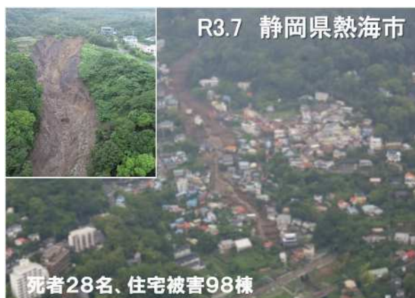
写真1 静岡県熱海市の土砂災害状況
