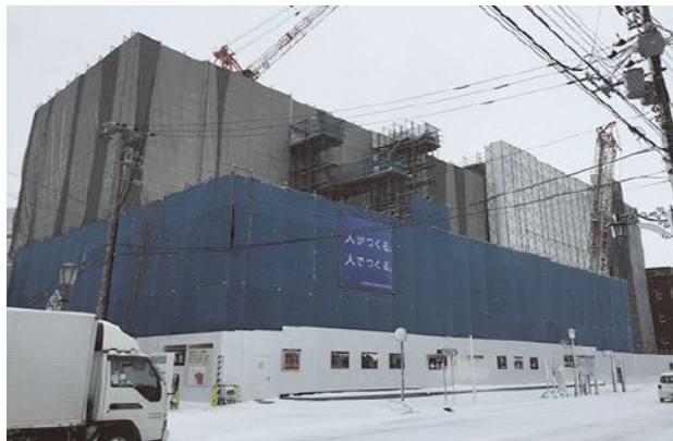
写真-3 減築棟、改修棟の外部足場と荷取構台
