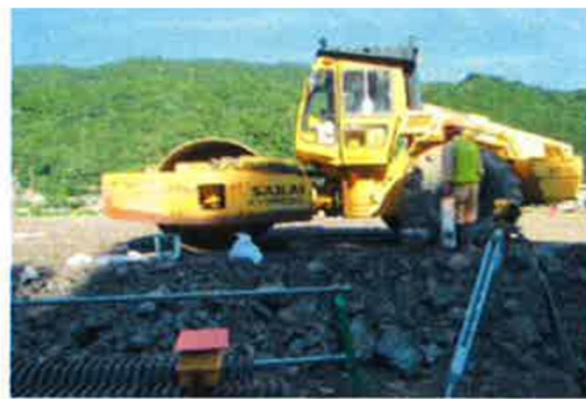
機械の大型化による盛土材への有効利用
