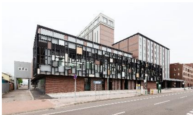
写真-11 減築後の躯体を再利用した建物
