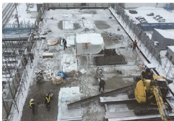
写真-10 5階床上の H 型鋼材撤去
