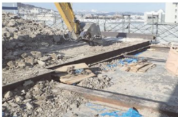
写真-9 解体完了後、H 型鋼材間のコンクリート塊撤去
