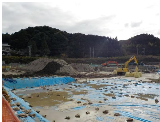
No. 6 【地区改良工事】
