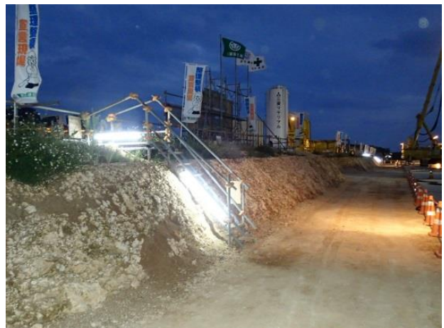
写真-11 夜間照明設置状況
