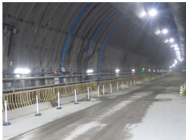
写真-8 トンネル坑内LED照明
