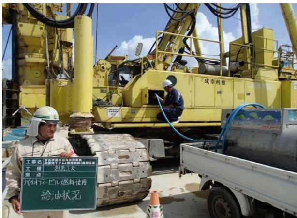
写真-9 BDF を使用している杭打ち機
