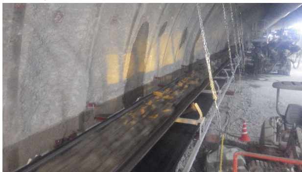
写真-6 ベルトコンベア運搬状況
