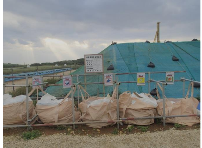
写真-4 分別ボックス設置・看板の掲示
