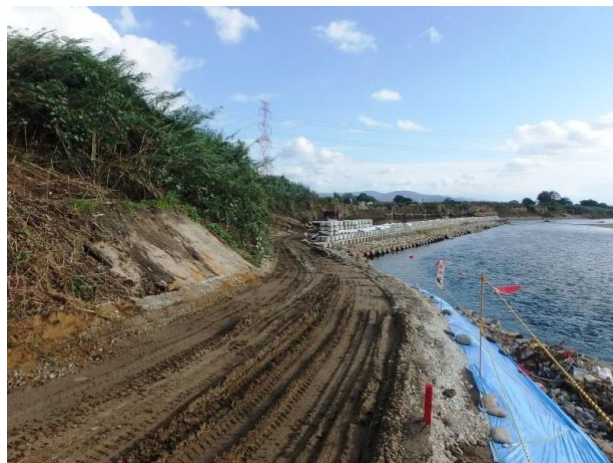
No. 4 【護岸他補修工事】
