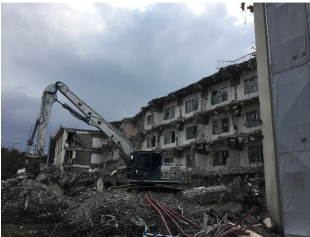
既存宿舎解体状況
