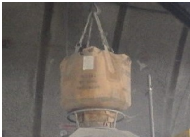
写真-4 ドライモルタル搬入状況 （容器の底が開閉する）
