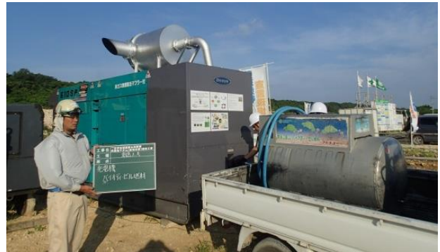
写真-10 BDF を使用している発電機
