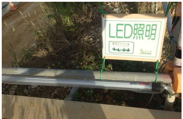
写真-12 LED スリムライト設置
