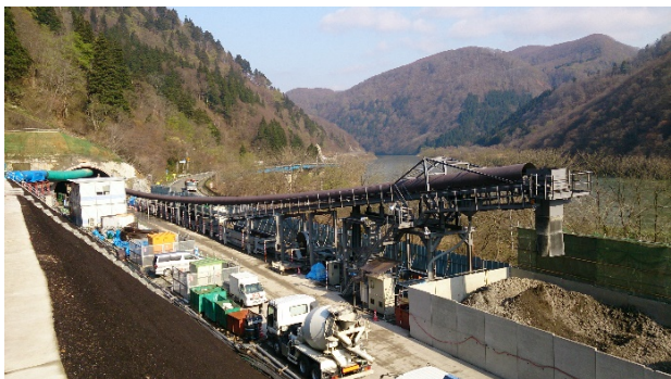
写真-7 ベルトコンベア終点部
