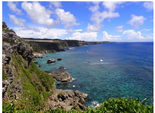
写真-2 地下ダム下流側(海側断崖)
