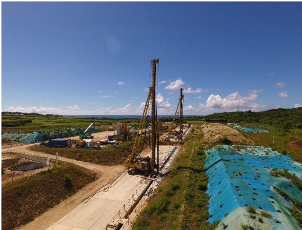
写真-3 施工状況全景
