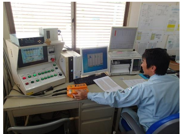
写真—7 吐出量管理状況
