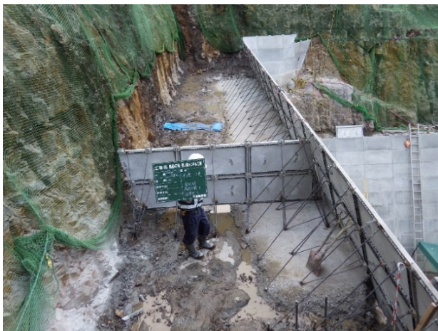
写真-3 埋設型枠組立状況
