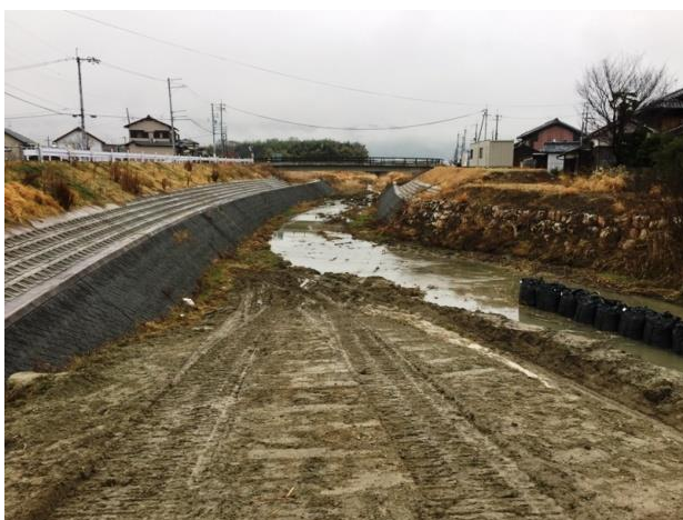
No. 8 【河川整備促進工事】
