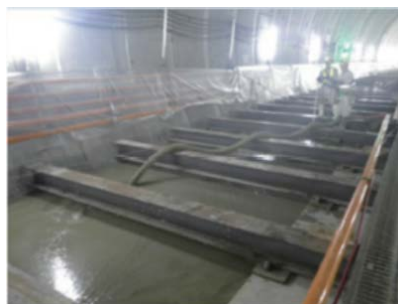
流動化処理土打設状況
