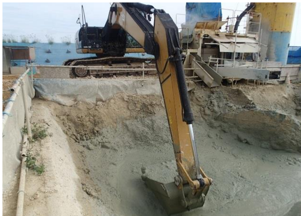
写真-13 建設汚泥の固化状況
