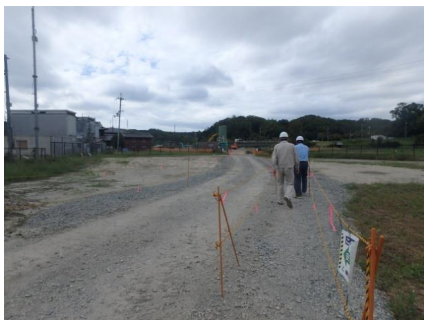
No. 1 【高架橋橋梁下部他工事】
