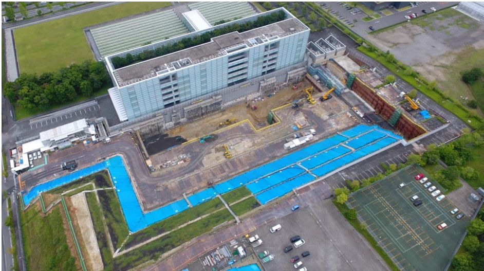
平成 29 年 7 月 造成工事完了
