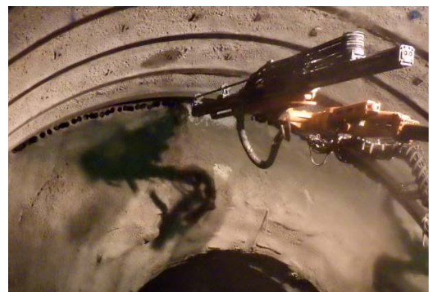
写真-11 スリット溝施工状況
