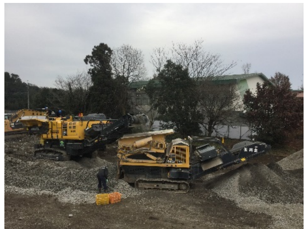
コンクリート塊の再生処理
