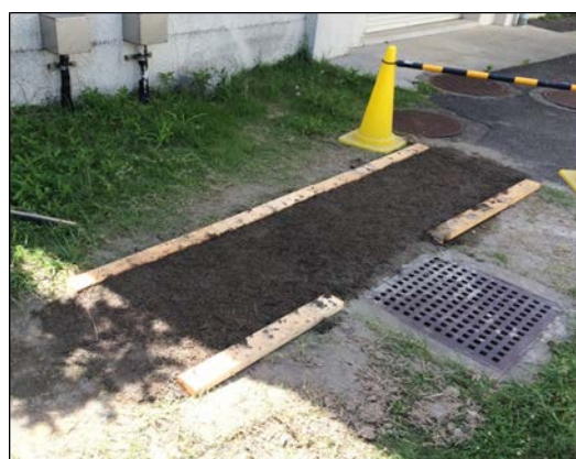
施工実験の様子
