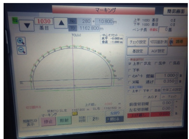
写真-2 トンネル情報化施工統合システム(モニタ画面)
