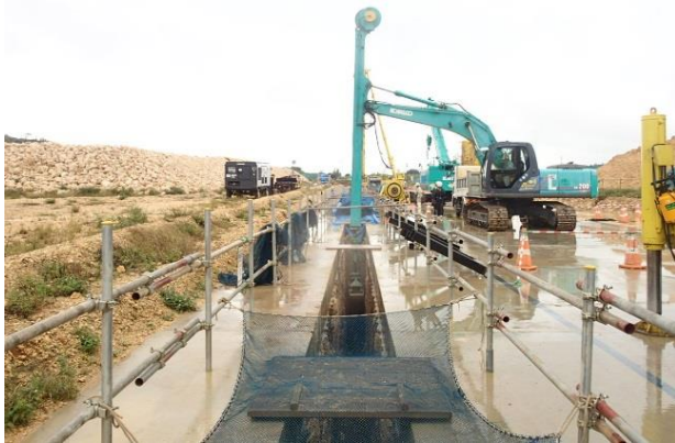
写真—5 泥土発生状況
