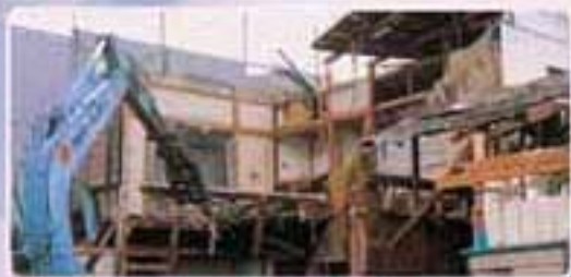
木造住宅解体
