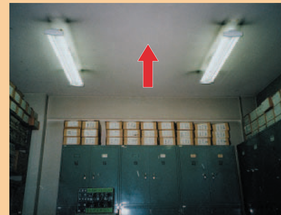
結露防止用の石綿含有パーミキュライト吹付け・パーライト吹付け (天井・壁等)
