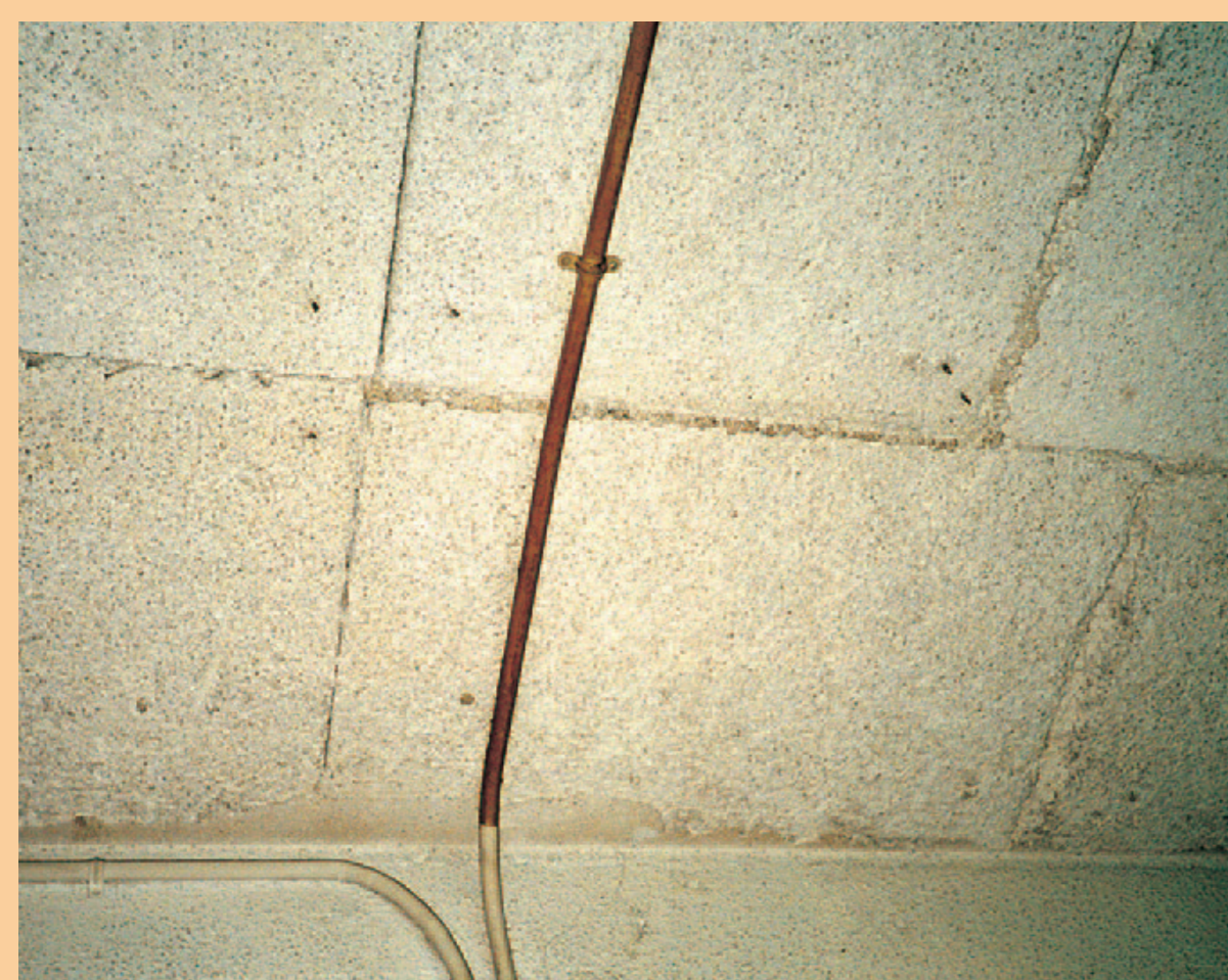
木毛セメント板 (打ち込み)
