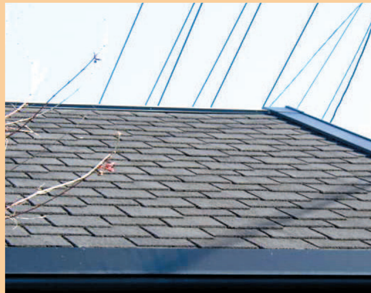
石綿含有住宅化粧用スレート (屋根)
