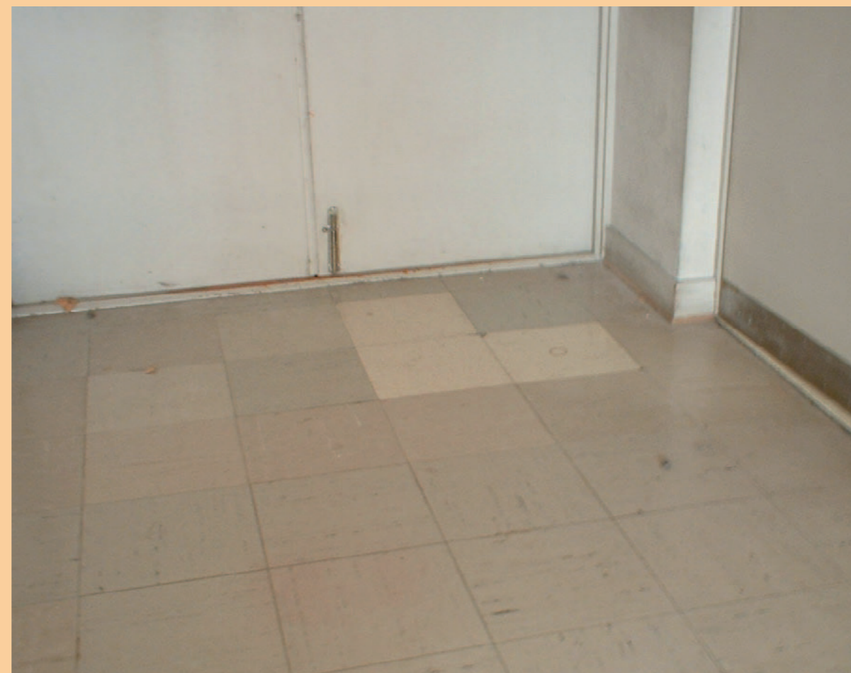
石綿含有ビニール床タイル (床)
