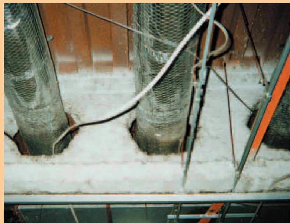
耐火被覆用吹付け石綿・石綿含有吹付けロックウール (S造の柱・梁等)
