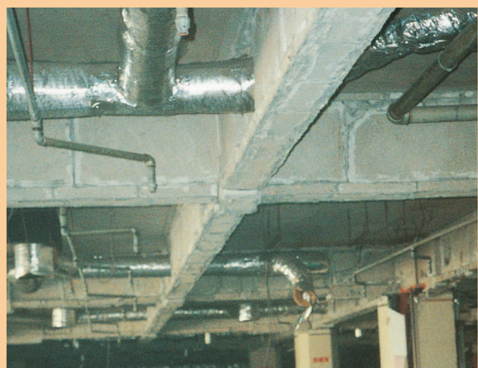
耐火被覆用石綿含有ケイ酸カルシウム板 (2種) (S造の柱・梁)
