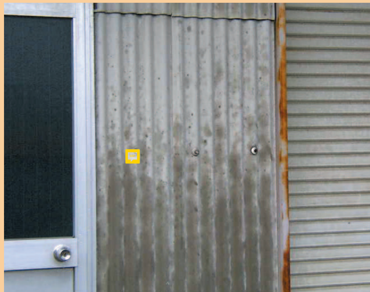
石綿スレート (屋根・外壁)
