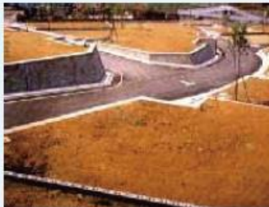
盛土、土地造成
