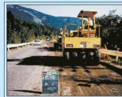
道路工事の 路盤材等への再生利用
