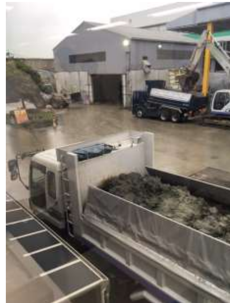
見学当日プラントの様子
