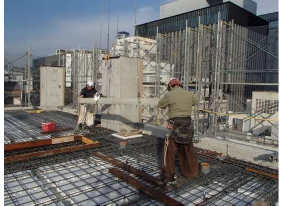
立上りサイトP C設置状況
