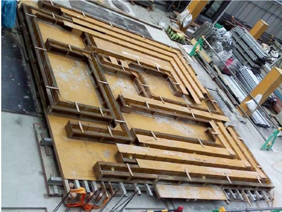
外壁立上りサイトP C 型枠組立状況
