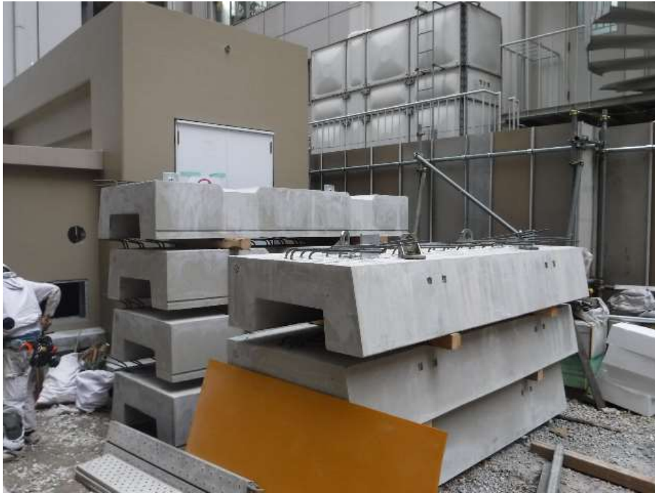
屋上ヘリポート外周躯体 サイトP C型枠脱型状況
