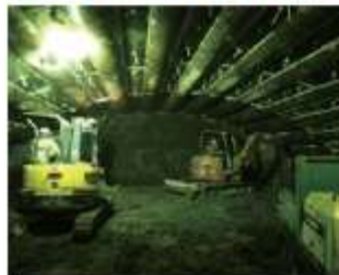
パイプルーファーチ下部全面掘削工
