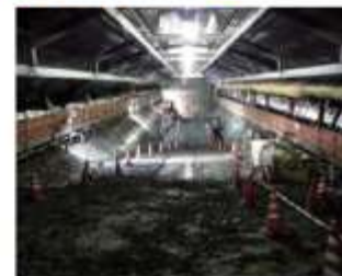
トンネル間掘削工
