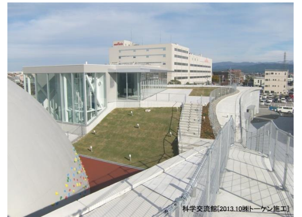
科学交遊館[2013.10棟トレーケン施工]
