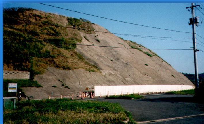
コンクリート吹付
