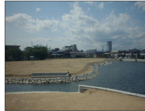
ボンテラン改良土による 施工箇所
