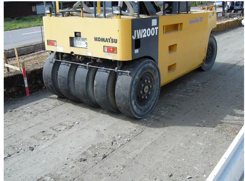
ボンテラン改良土の 締固め状況
