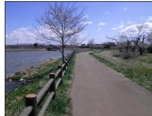
ボンテラン改良土による 施工箇所
