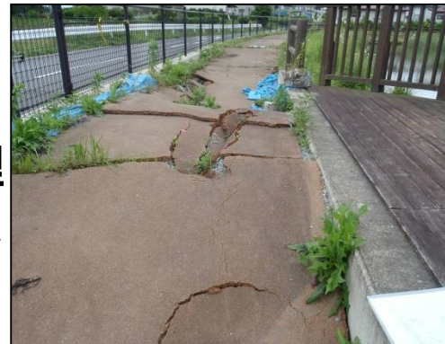
浅層混合処理工法による 施工箇所
