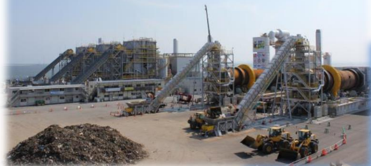
稼働中の仮設焼却炉(左:ストーカ炉 右:キルン炉) 東日本大震災 災害廃棄物処理の報告書(日建連)より引用
